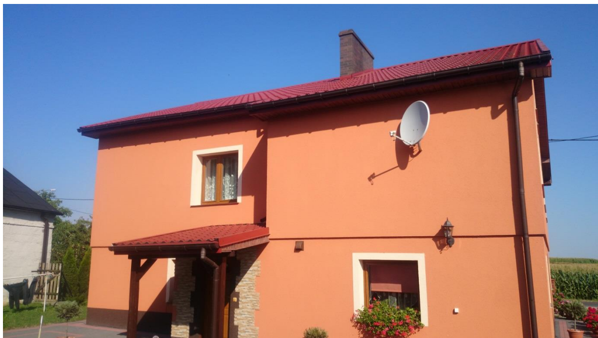
Połąc dachowa przewidziana na montaż instalacji fotowoltaicznej.
