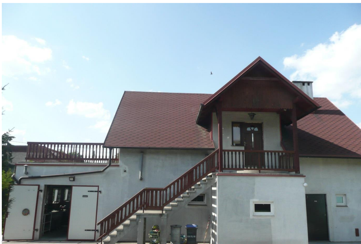
Połąc dachu przewidziana na montaż instalacji fotowoltaicznej.
