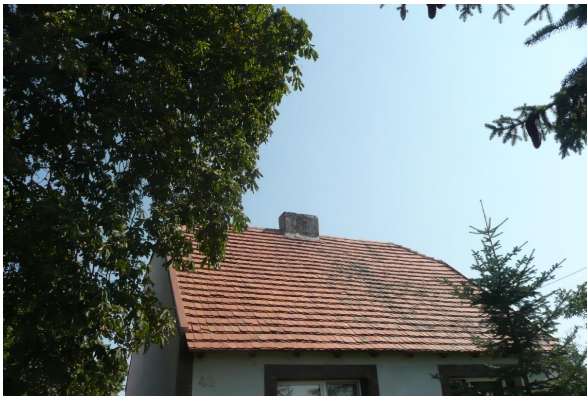
Połąć dachowa przewidziana na montaż instalacji fotowoltaicznej.
