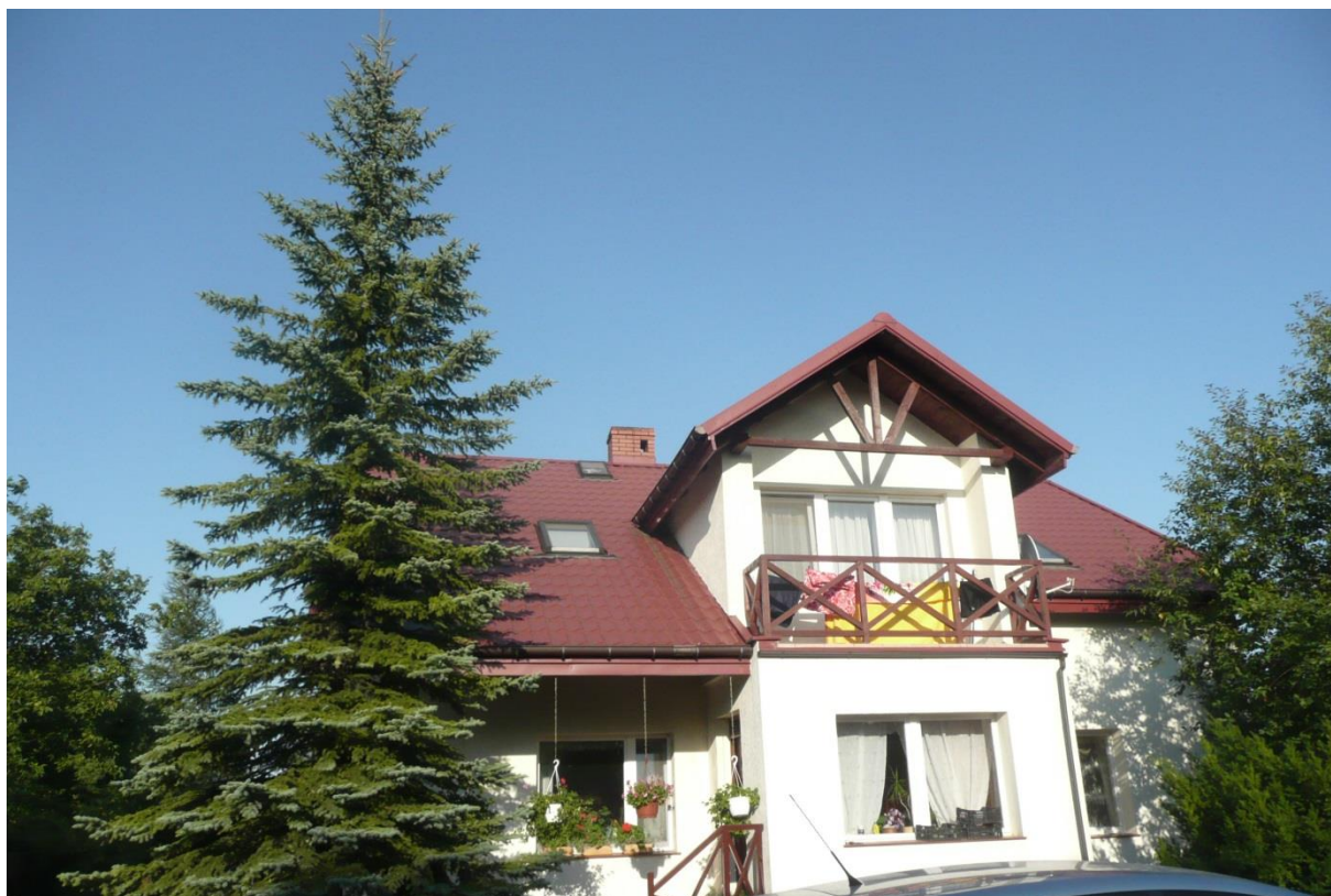
Połącze dachowe przewidziane na montaż instalacji fotowoltaicznej.
