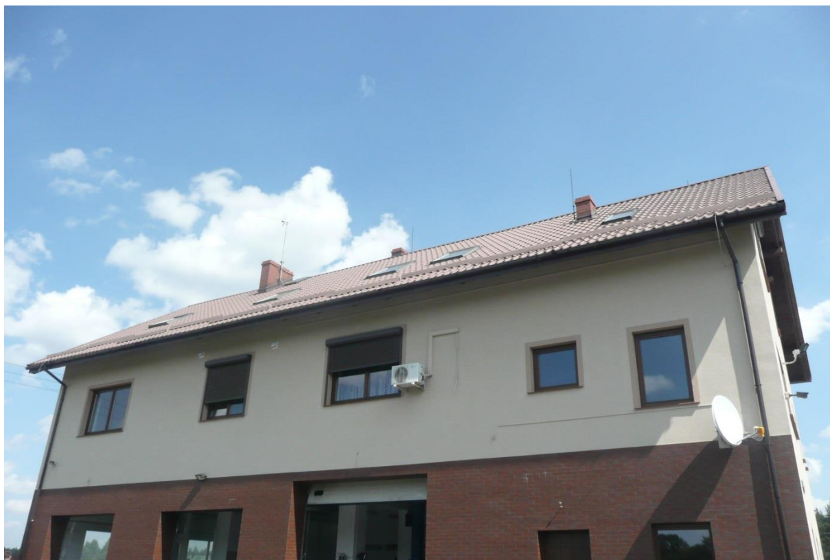
Połąc dachowa przewidziana na montaż instalacji fotowoltaicznej.
