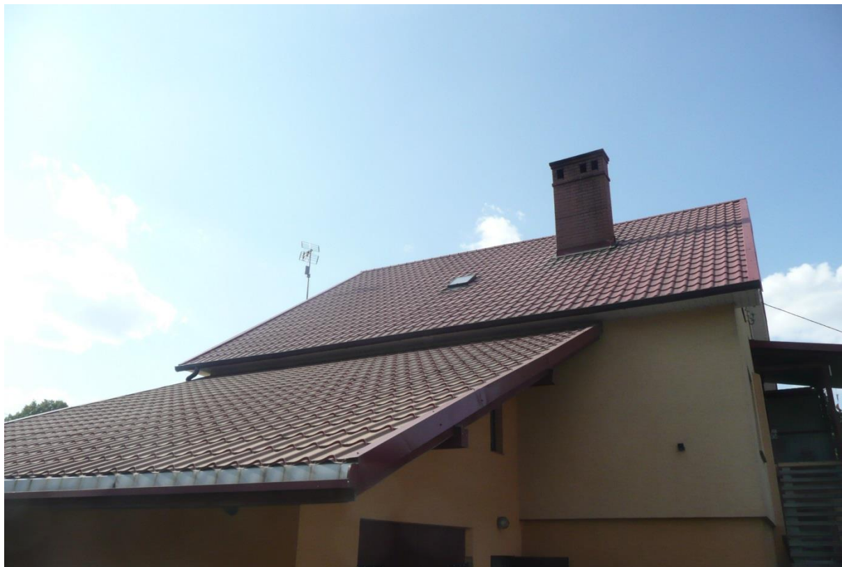
Połąc dachu przewidziana na montaż instalacji fotowoltaicznej.
