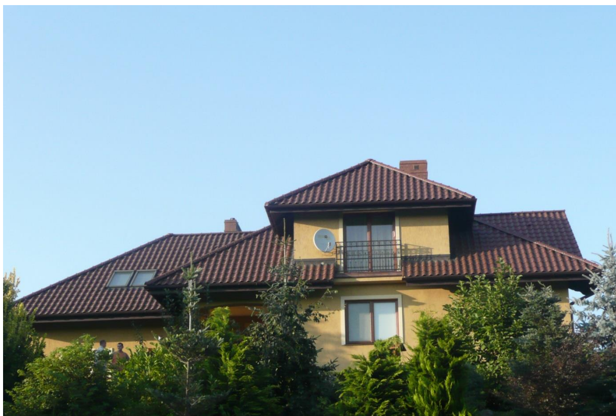
Połączenie dachu przewidziane na montaż instalacji fotowoltaicznej.
