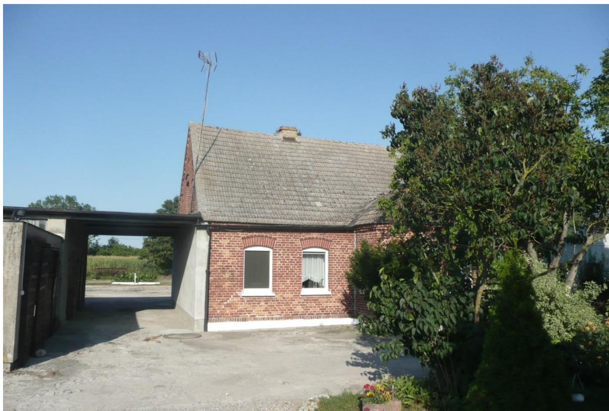
Połąc dachu przewidziana na montaż instalacji fotowoltaicznej.
