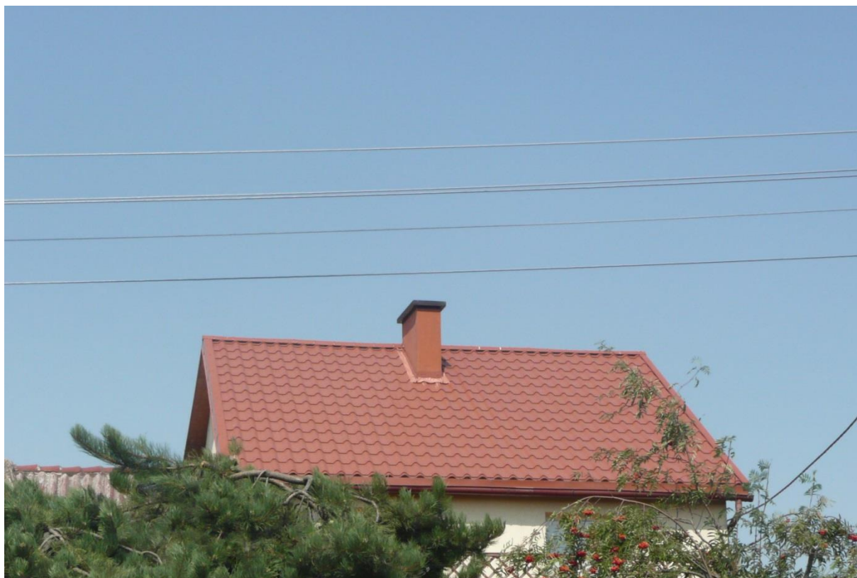
Połączenie dachu przewidziane na montaż instalacji fotowoltaicznej.
