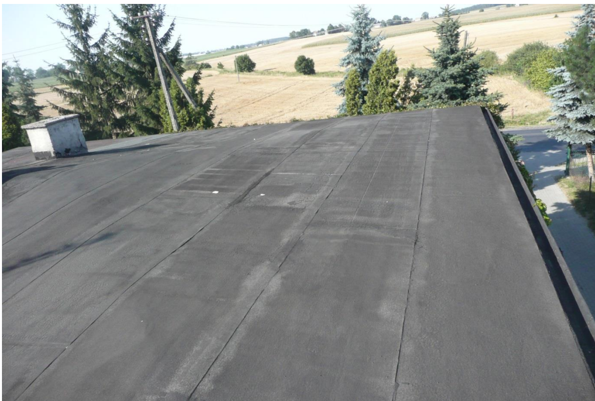
Połącze dachowa przewidziana na montaż instalacji fotowoltaicznej.
