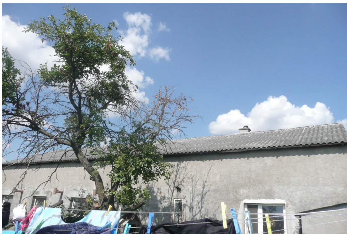
Połączenie dachu przewidziane na montaż instalacji fotowoltaicznej.
