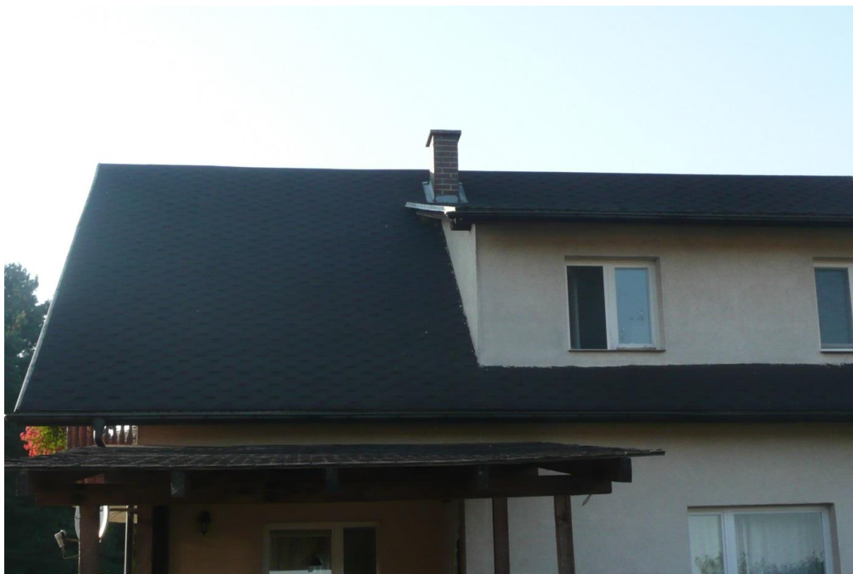
Połąć dachowa przewidziana na montaż instalacji fotowoltaicznej.
