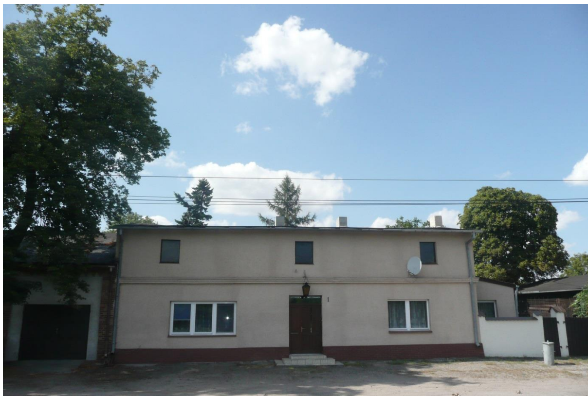
Połączenie dachu przewidziane na montaż instalacji fotowoltaicznej.
