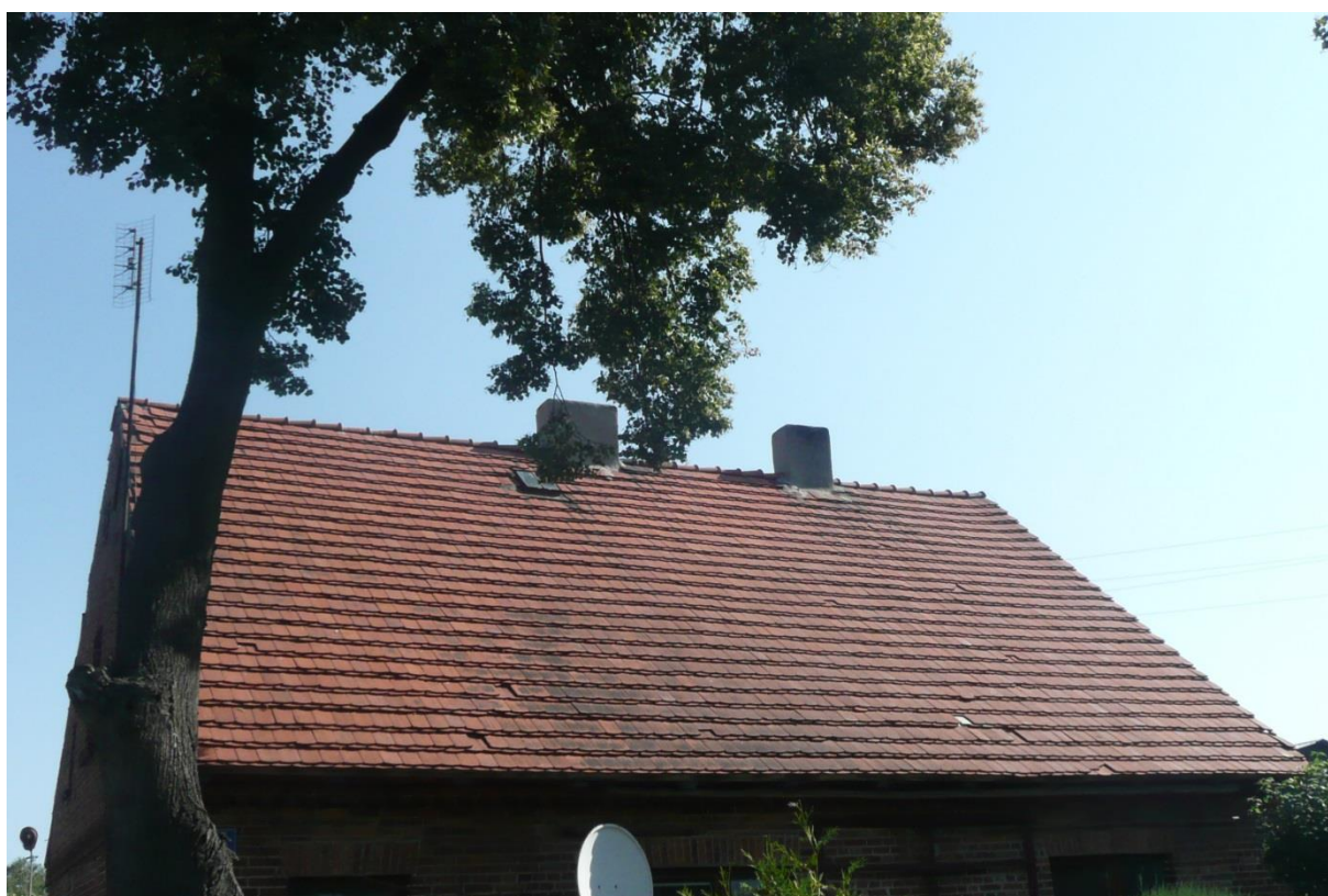
Połąc dachu przewidziana na montaż instalacji fotowoltaicznej.
