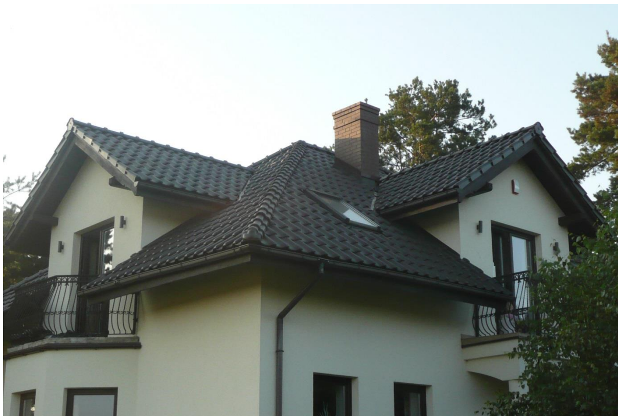
Połącze dachowe przewidziane na montaż instalacji fotowoltaicznej.
