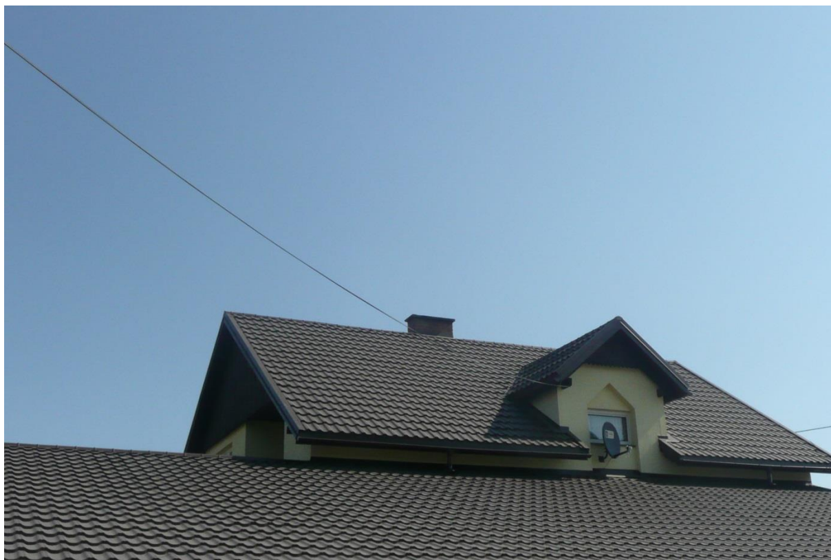
Połąc dachu przewidziana na montaż instalacji fotowoltaicznej.
