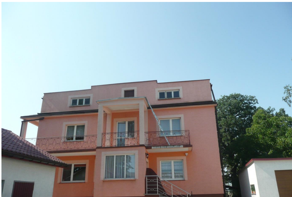
Budynek przewidziany na montaż instalacji fotowoltaicznej – instalacja na dachu płaskim.
