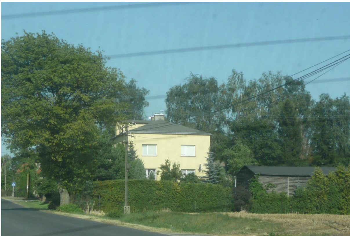
Połącze dachowe przewidziane na montaż instalacji fotowoltaicznej.
