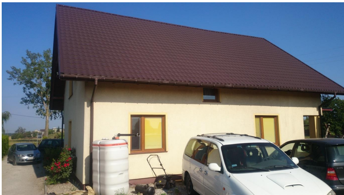
Połąć dachowa przewidziana na montaż instalacji fotowoltaicznej.
