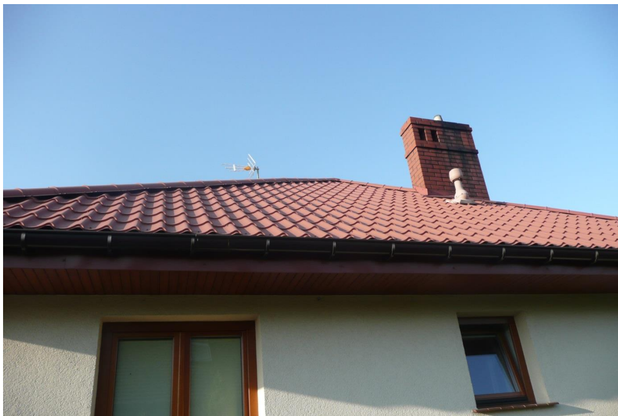
Połącze dachowe przewidziane na montaż instalacji fotowoltaicznej.
