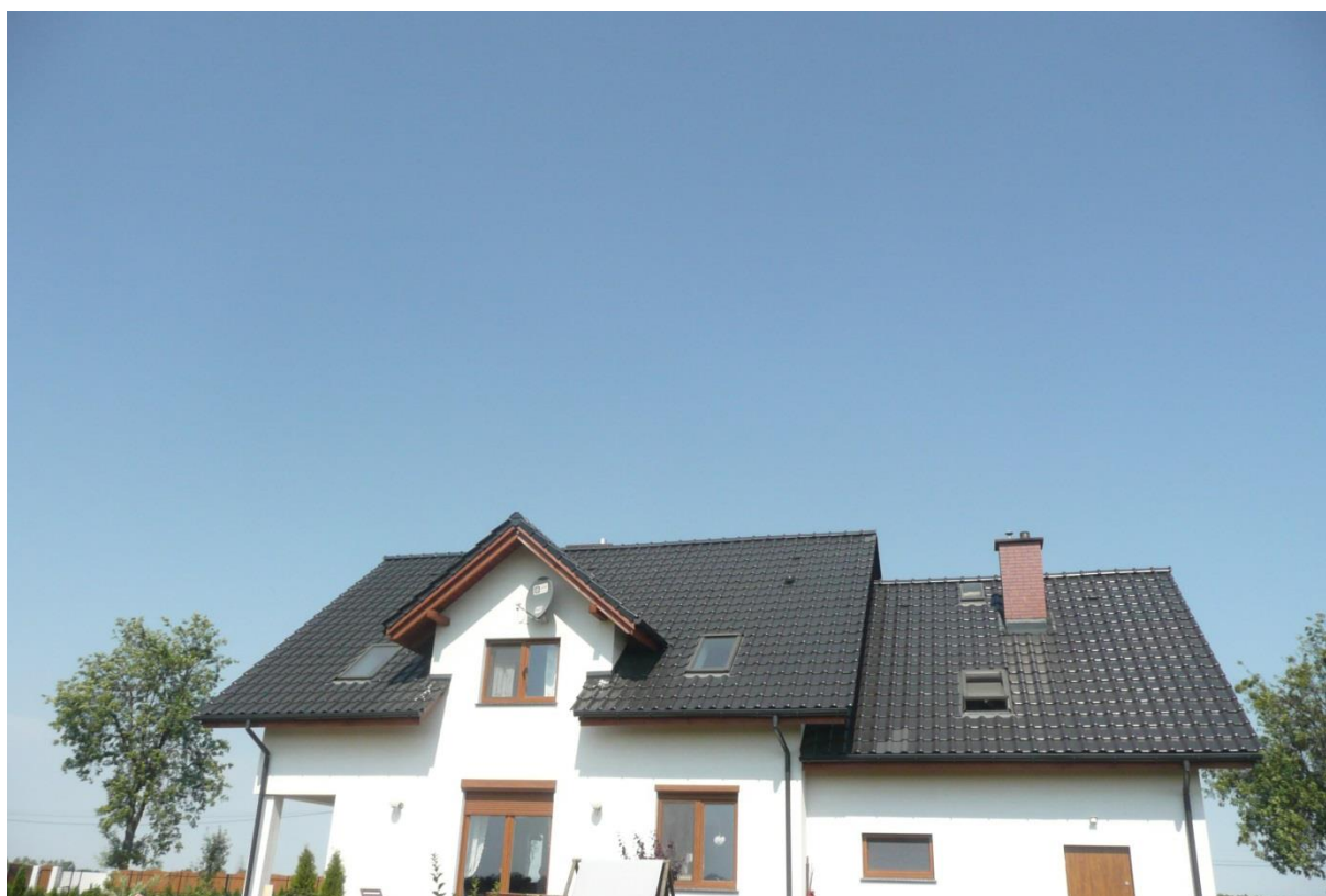
Połąc dachu przewidziana na montaż instalacji fotowoltaicznej.
