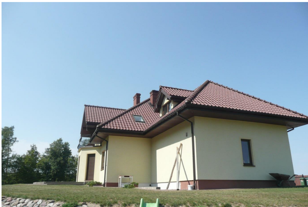
Połącze dachowe przewidziane na montaż instalacji fotowoltaicznej.
