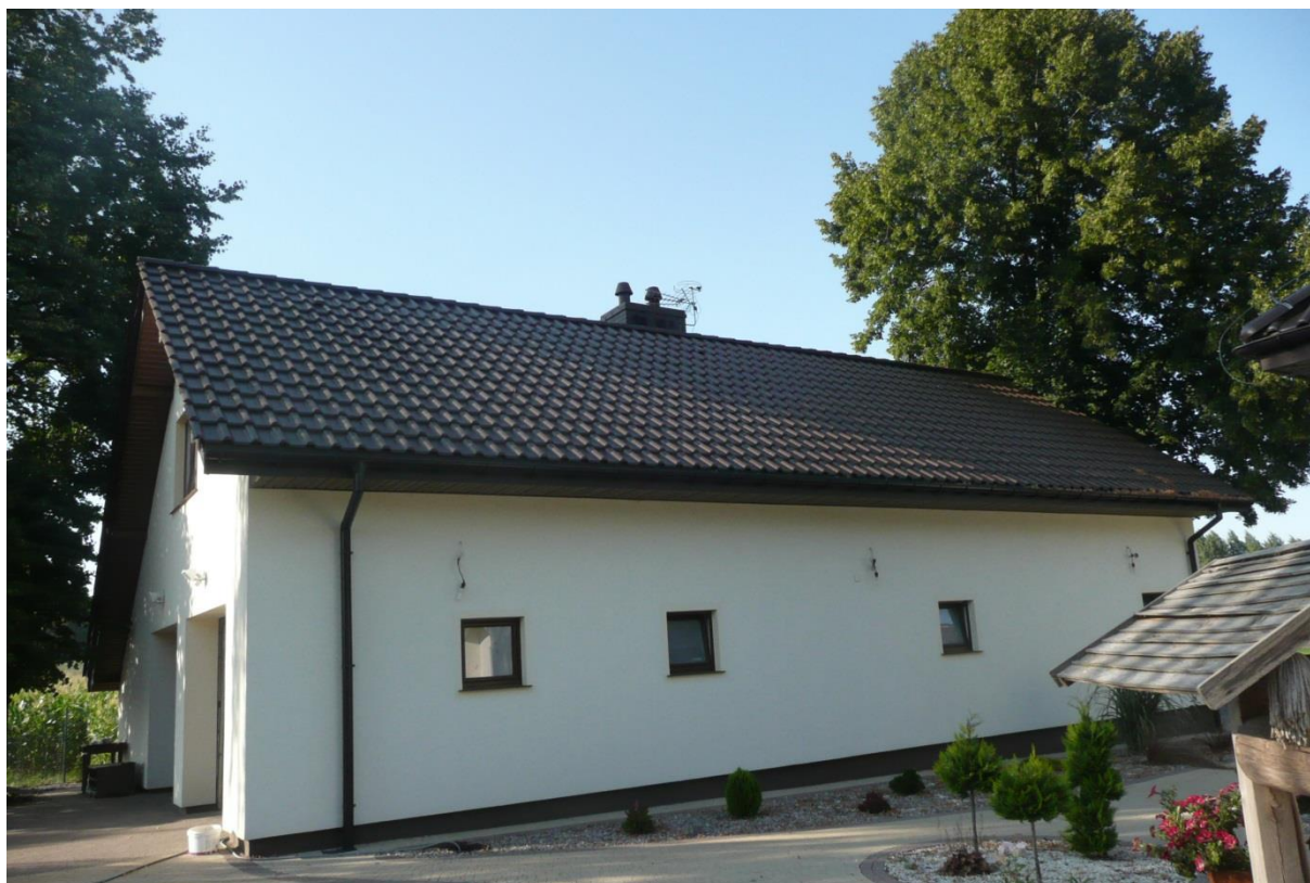
Połąć dachowa przewidziana na montaż instalacji fotowoltaicznej.
