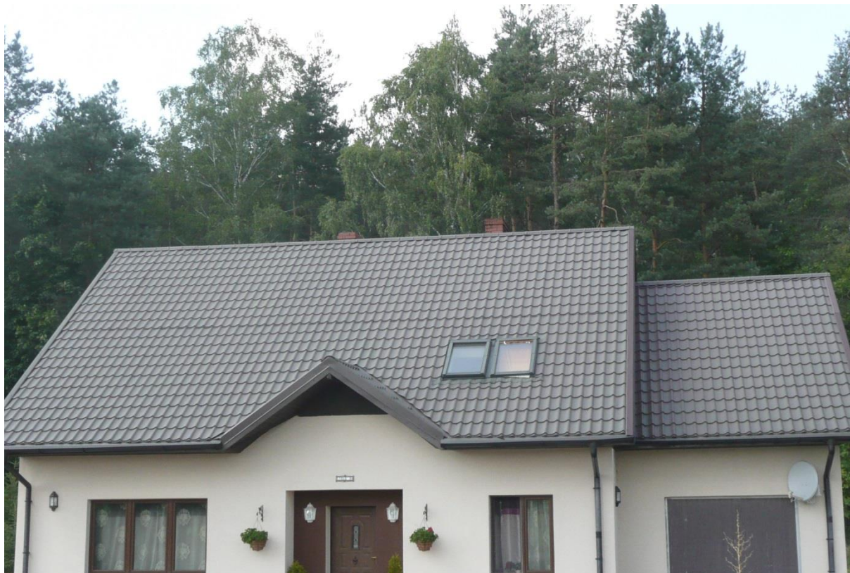
Połącze dachu przewidziana na montaż instalacji fotowoltaicznej.
