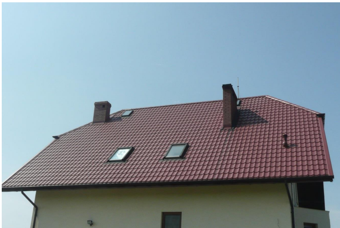
Połącze dachu przewidziane na montaż instalacji fotowoltaicznej.
