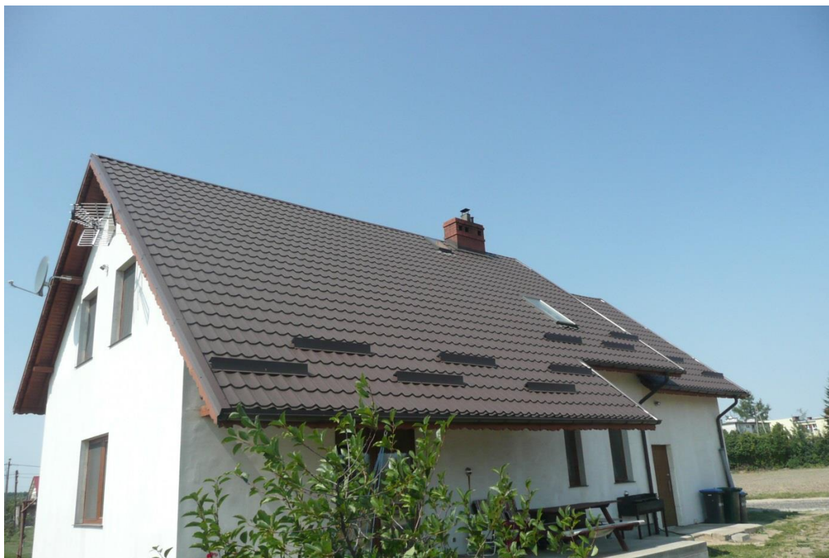
Połącze dachu przewidziane na montaż instalacji fotowoltaicznej.
