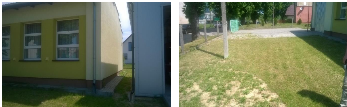
Zdjęcie 2. Świetlica wiejska w Owieczkowie i niezagospodarowany teren przed budynkiem świetlicy
