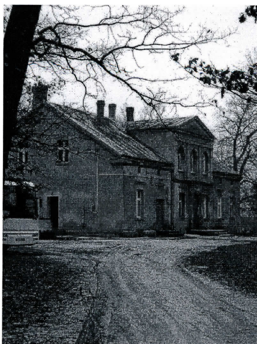
Fot. nr 1: Dworek w Gałczewku – stan obecny (fot. Franciszek Gutowski)
