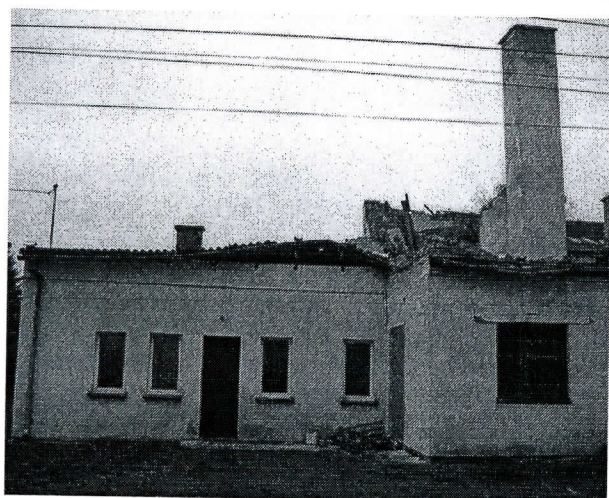
Fot. 12, 13, 14: Detale: uszkodzony dach, ściana i elewacja (fot. Franciszek Gutowski)
