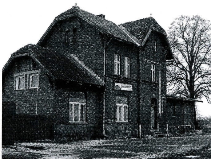
Fot. nr 2: Stacja kolejowa w Gałczewku - stan obecny (fot. Franciszek Gutowski)
