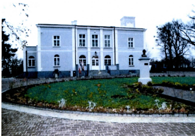
Rys.13 - Ośrodek Chopinowski w Szafarni.
